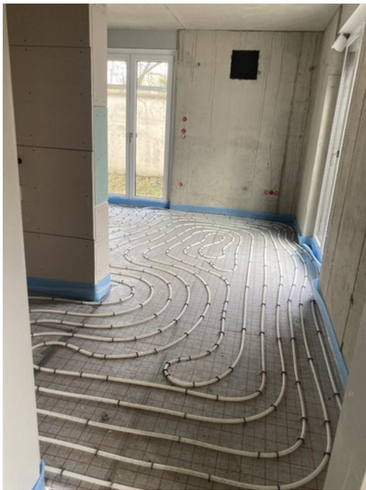
Im Haus 3 ist für den Estrich alles vorbereitet. Dieser soll im Laufe der nächsten Tage eingebracht werden. Dann folgt die Trocknungsphase. Am Trockenbau finden erste Folgearbeiten statt. Die Heizung wird zum Aufheizen des E-Striches vorbereitet.
