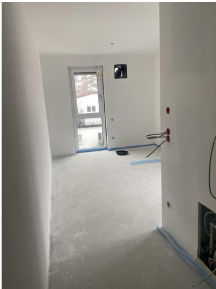
Es werden im Haus 2 die Böden zum Verlegen vorbereitet und auch bereits teilweise verlegt. Die fertig gefliesten Bäder werden verfugt und silikoniert. Hier laufen die Vorbereitungen für die Fertiginstallation der Gegenstände.
