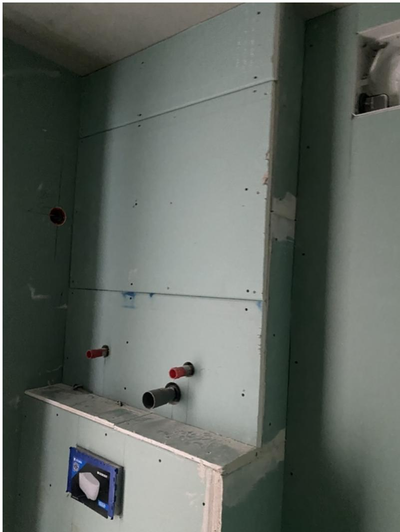
Im Haus 1 spachtelt der Trockenbauer alle Wände. Die Vorbereitungen für das Abdichten der Bäder und somit für die Fliesen laufen. Der Maler wird auch hier bald starten.
