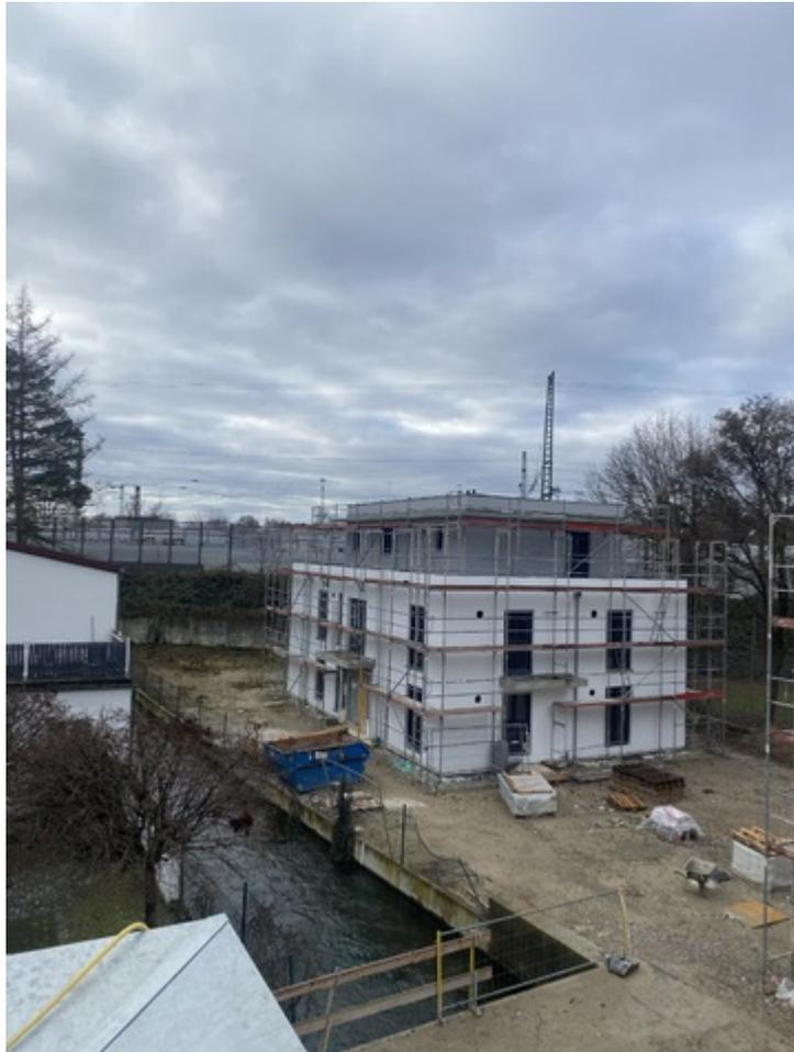
Im Haus 5 wird in den nächsten Tagen der Innenputz angebracht. Außen sind die Malerarbeiten erledigt und die Spenglerarbeiten sind in den letzten Zügen. In der kommenden Woche wird das Gerüst abgebaut.
