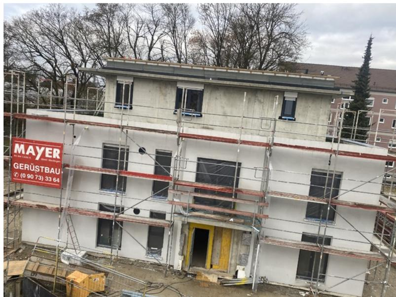
Im Haus 4 ist die Grundinstallation der Heizungs- und Sanitärarbeiten abgeschlossen. Die Aussparungen werden geschlossen und anschließend kann der Trockenbau weitergehen. An der Fassade ist im EG und 1.OG die Dämmung angebracht. Das Dachgeschoss steht noch aus. Je nach Wetterlage wird dies in der nächsten Zeit erledigt. Den Putz werden wir erst nach den kalten Tagen auftragen können.
